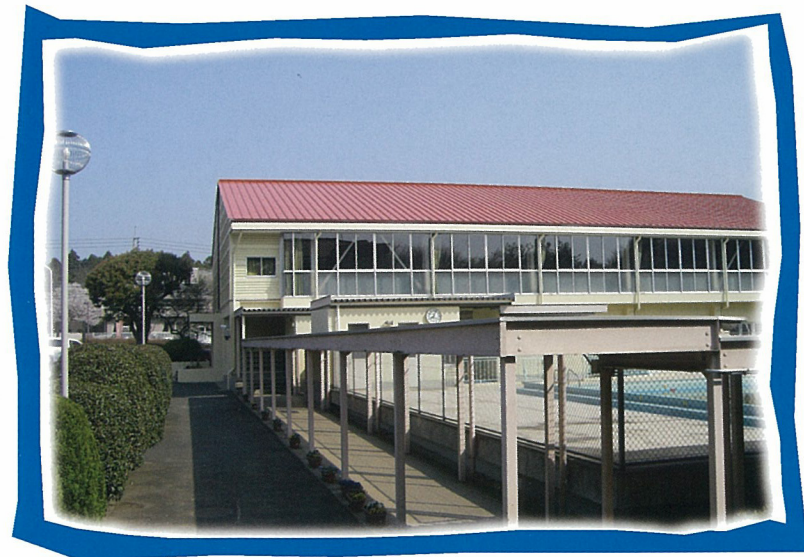
— 平成20年度 全面改修された体育館 —
